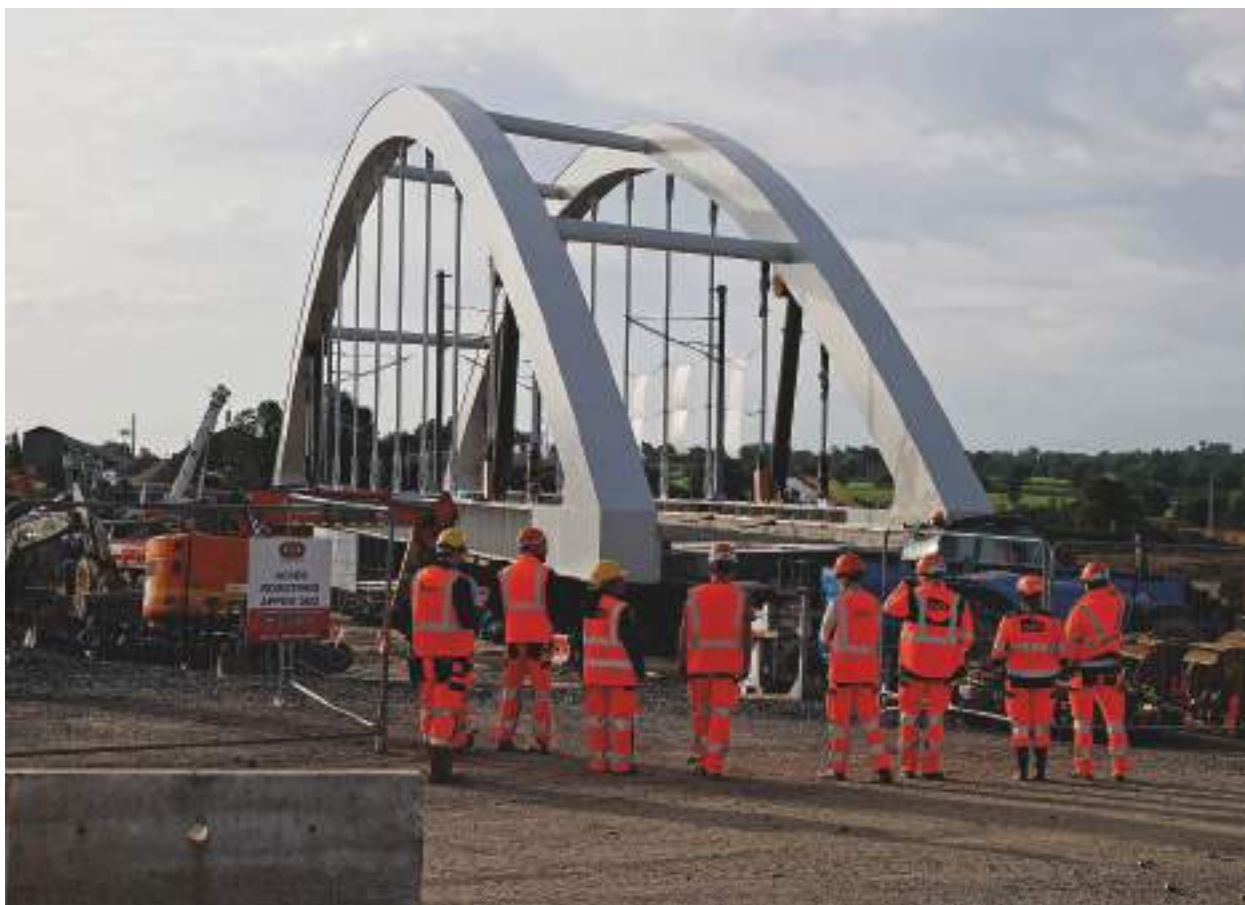
Pont ferroviaire d'Avesnelles - © Région Hauts-de-France / D. Bokalo
